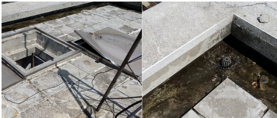
十三樓通往水塔的 2 個不銹鋼門蓋維修及各洗 2 個排水孔
